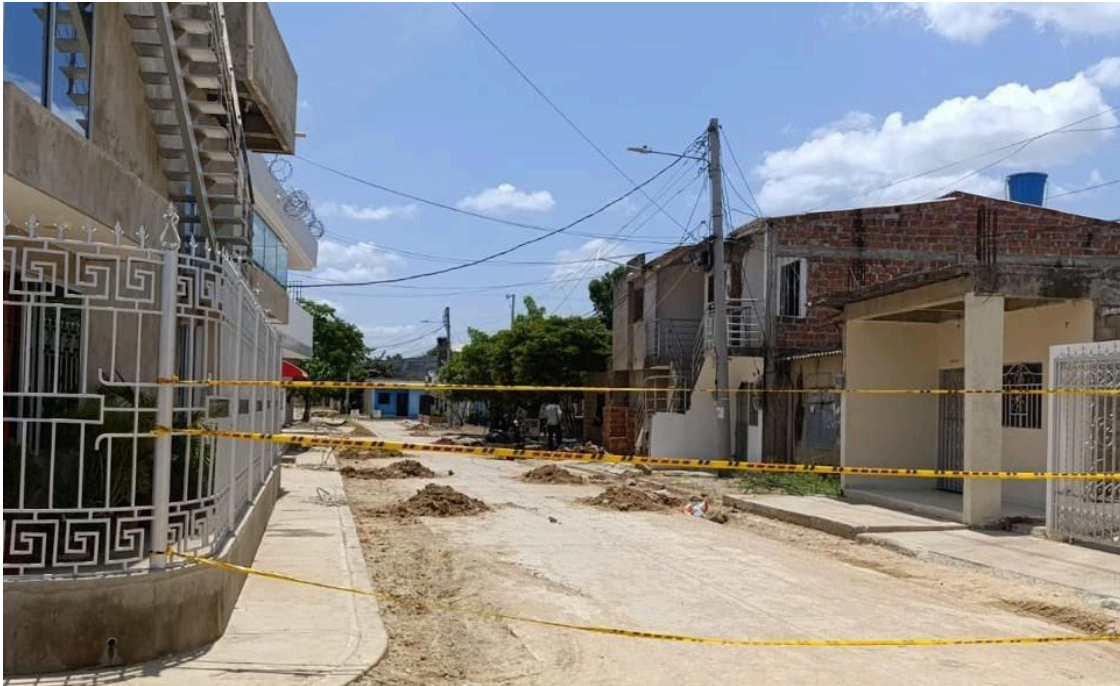
En estos sectores de la ciudad, continúan los trabajos que han afectado en el suministro de agua y nadie responde.
