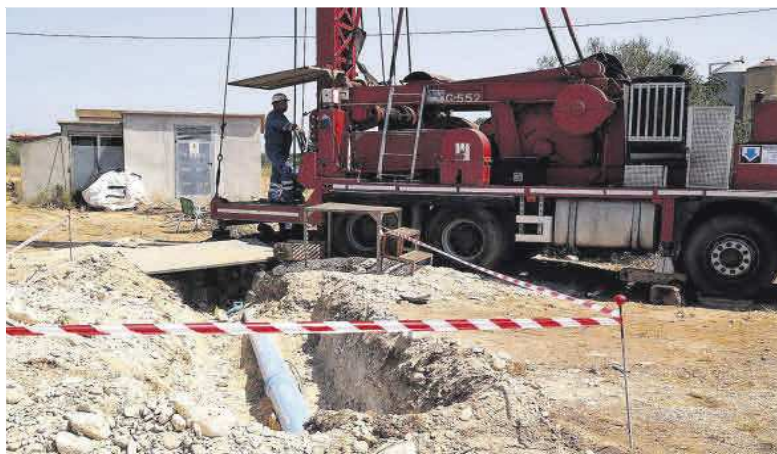
Obras en Ulldecona para adecuar nuevos pozos contra la sequía.
