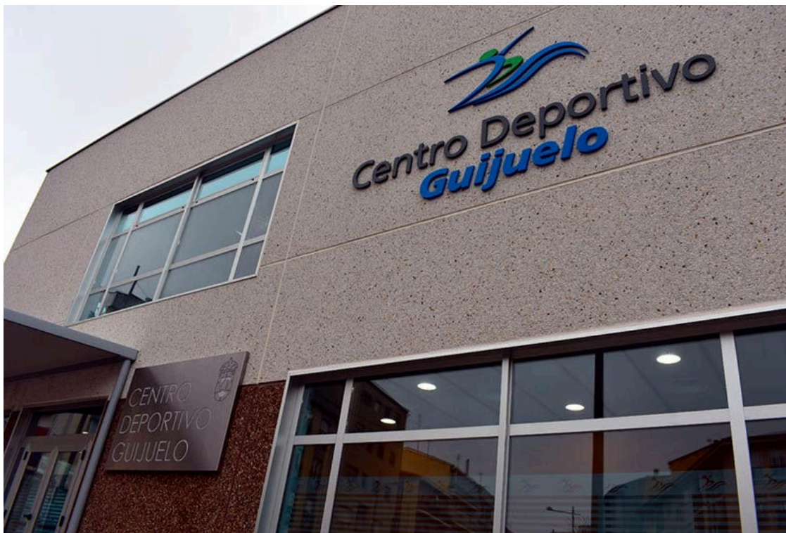
Entrada al centro deportivo.
