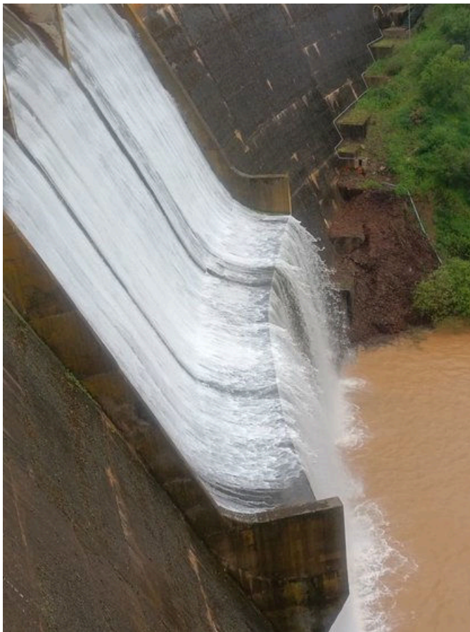
Presa de Fresnedas
